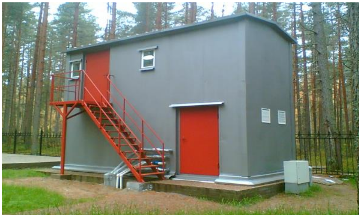
Фигура 36 Общ вид на сградата с монтираните в нея съоръжения за пречистване на отпадъчните води, на две нива. Под сградата се намира приемния буферен бетонов резервоар
