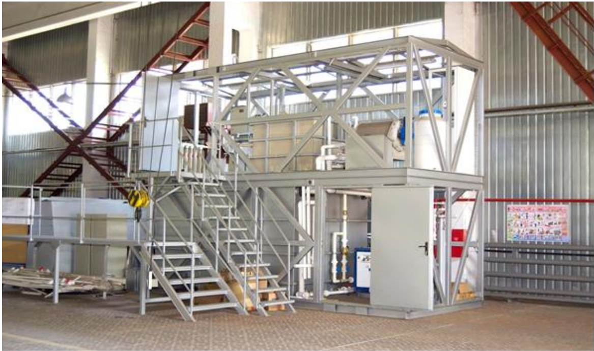
Фигура 37 Вътрешния скелет на сградата, в която на две нива се монтират съоръженията за пречистване на отпадъчните води
