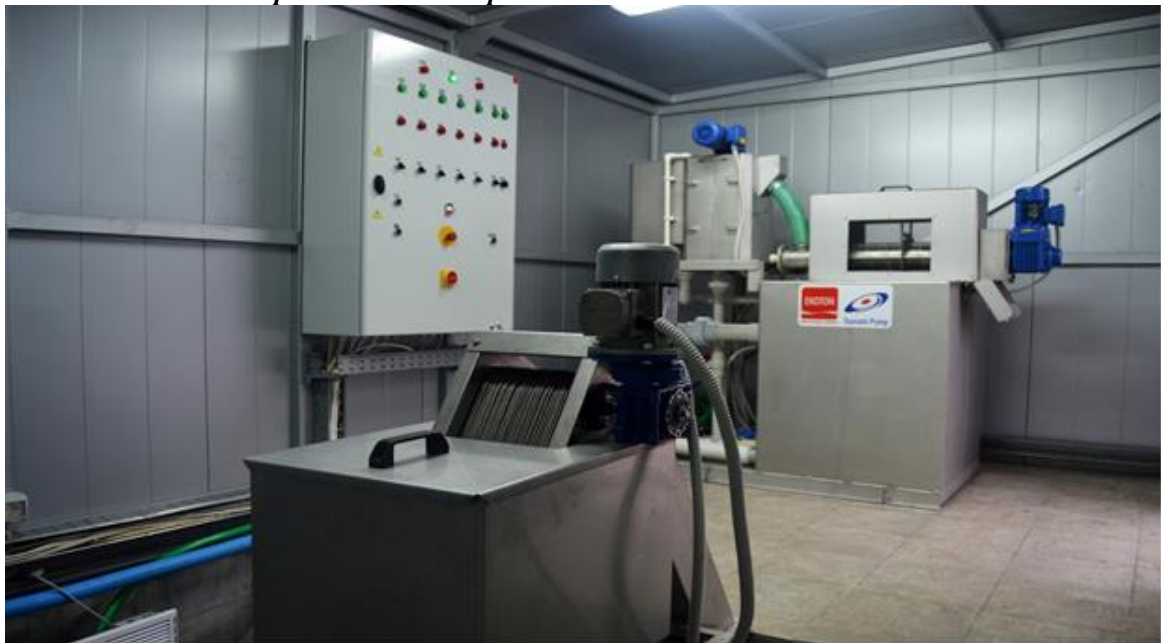
Фигура 38 Съоръженията от механичното пречистване на отпадъчните води в модулната пречиствателна станция. На преден план е механичната решетка за фино пречистване. На заден план е дехидратора за обезводняване на утайките
